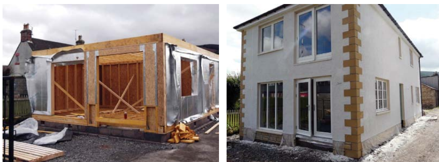
Fot. 3. Strong-portal™ – drewniana rama usztywniająca i jej zastosowanie.
