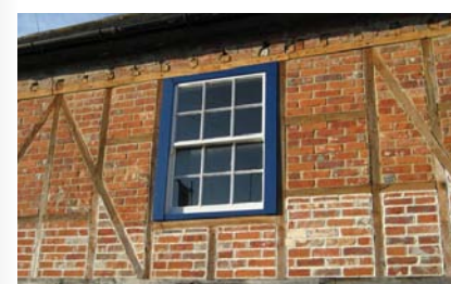
Fot. 3. Usztywnienie zastrzałami na przykładzie muru pruskiego. (zdj. Wikipedia.org)
