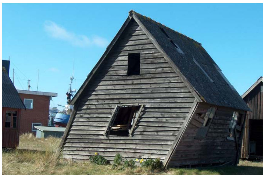
Fot. 1. Problem sztywności domów drewnianych.
