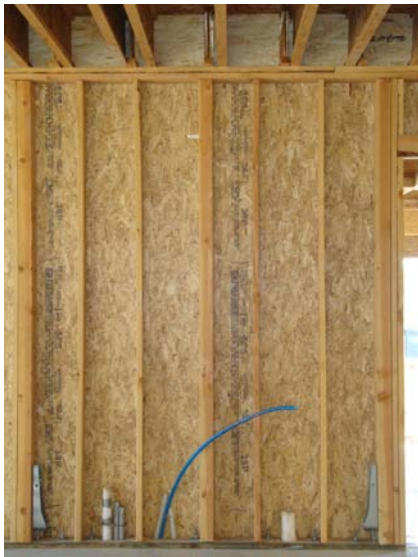
Fot. 5 Zakotwienie ściany usztywniającej do fundamentu
