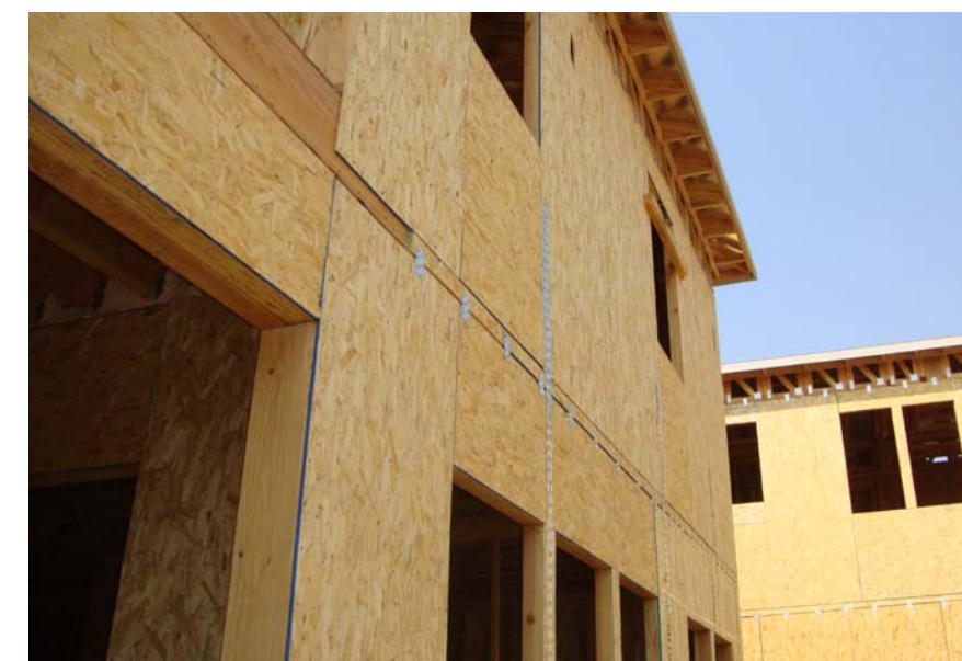
Fot. 4. Domy drewniane usztywnione poszyciem OSB.
