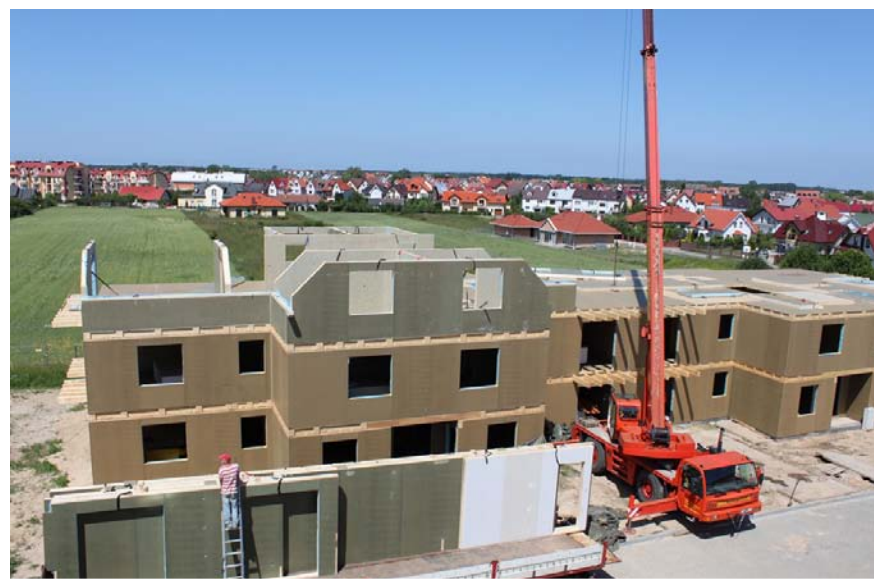
Fot. 1. Montaż prefabrykowanych ścian szkieletowych (wykonawca Trak-Bud).
